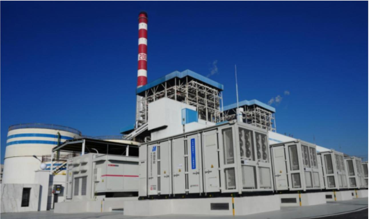
该电站由华能阳逻电厂与西安热工研究院联合研发，建设14兆瓦磷酸铁锂电池+6兆瓦超级电容混合储能调频系统，通过耦合2台64万千瓦高效超临界燃煤发电机组，以“机组+储能”联合调节模式参与电网调频。电站可以充分发挥超级电容储能的快速性和锂电池储能的持久性，实现电能快速、安全、大容量存储和释放，满足电网的调频需求。
